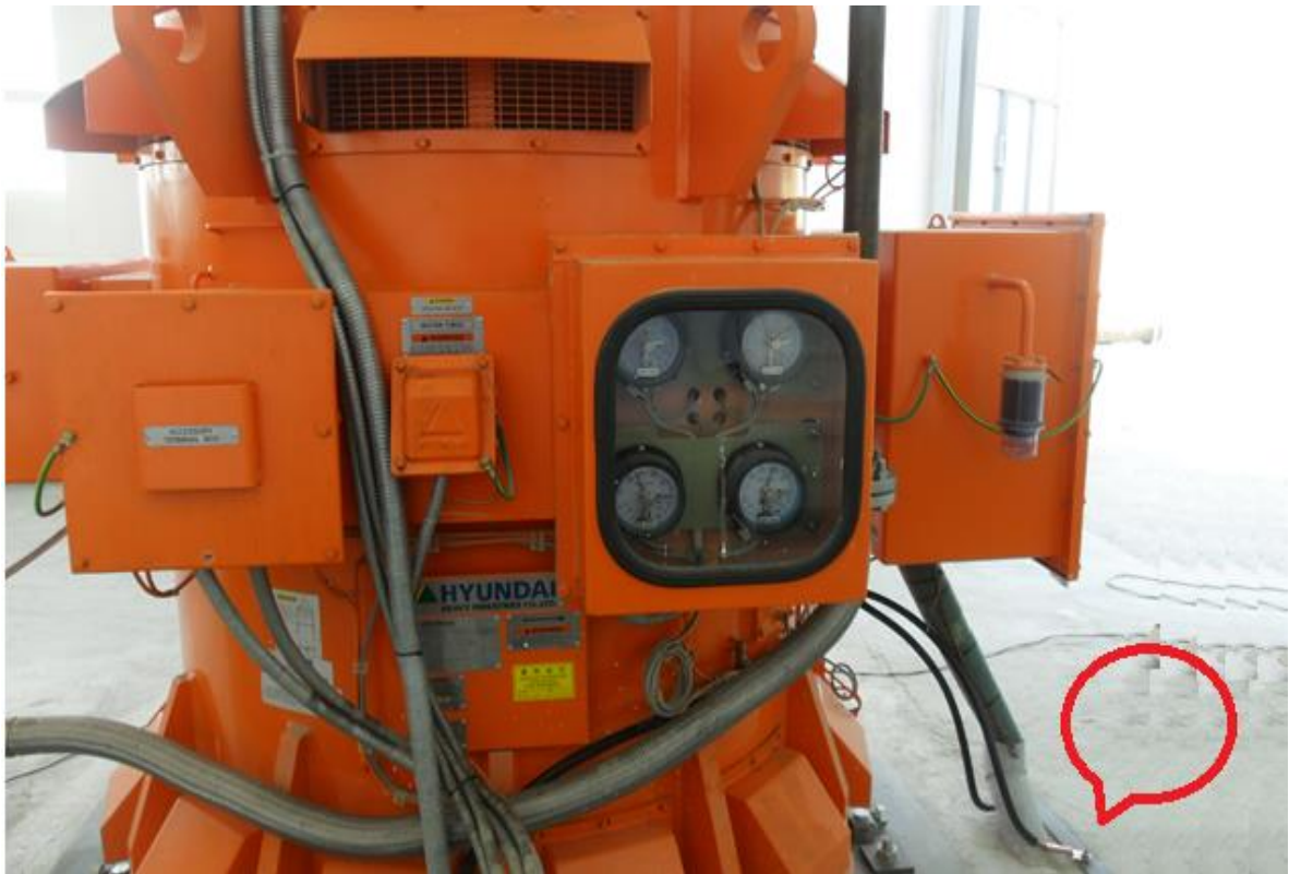
16.2 - rasm. Vertikal holatda oʻrnatilgan elektr dvigatelning yerga ulanish konturiga ulanishi
