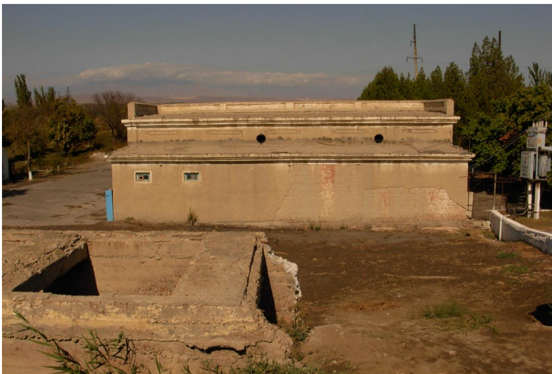
1.4 – rasm. Fargʻona viloyatidagi qayta qurish rejasiga kiritilgan «Dangʻara» nasos stansiyasining umumiy koʻrinishi
