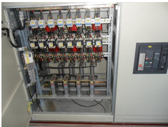
13.4 – rasm. Elektr tarmog'ining reaktiv quvvatini kompensatsiyalash qurilmasi
