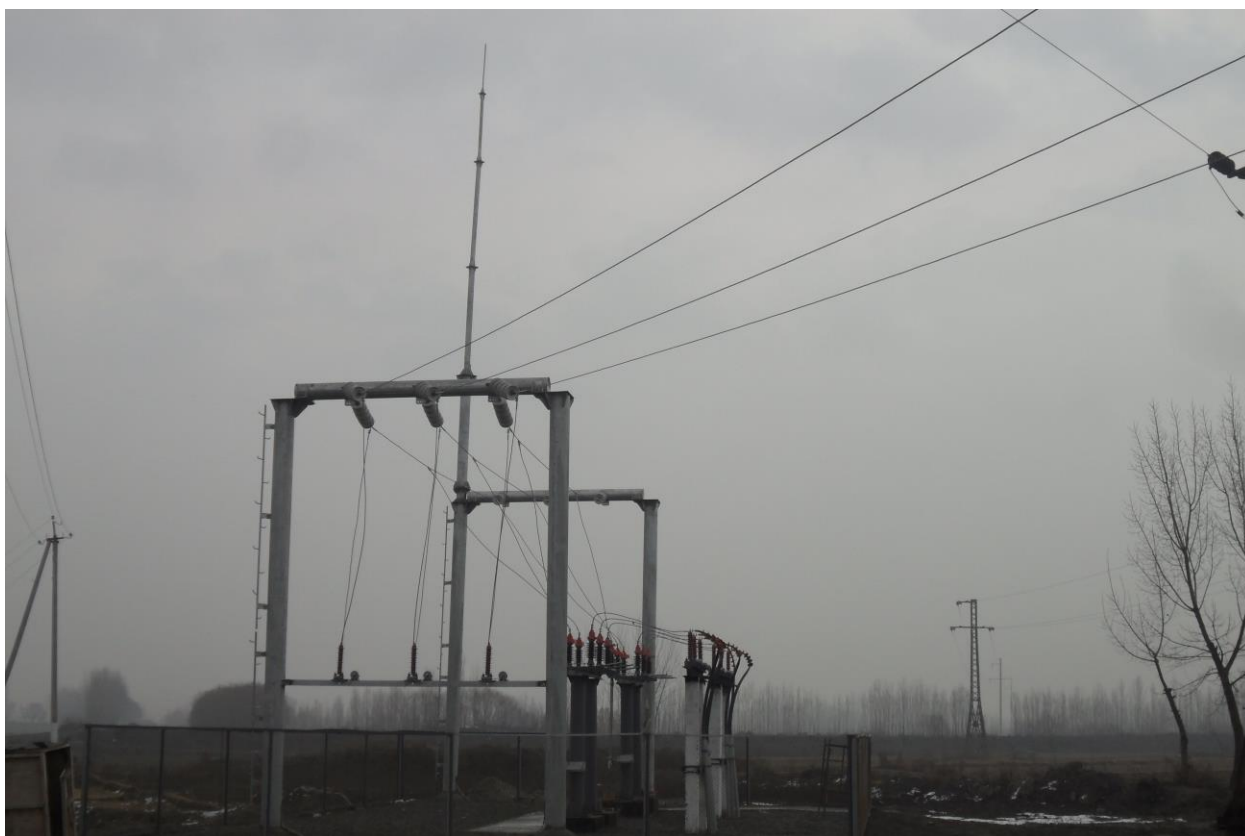
15.1 - rasm. Kuchlanishi 35 kV li havo liniyasini atmosfera yuqori kuchlanishidan himoyalash qurilmasi
