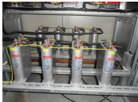
13.4 – rasm. Elektr tarmog'ining reaktiv quvvatini kompensatsiyalash qurilmasi
