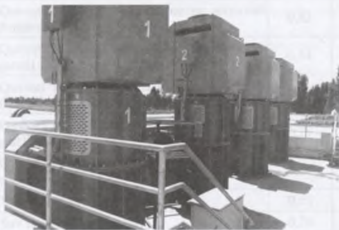
8.1-rasm. Vertikal holatda o'rnatilgan sug'orish nasoslarining uch fazali elektr dvigatellari.
