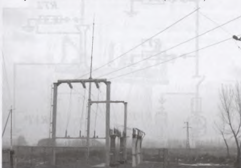
15.1-rasm. Kuchlanishi 35 kV li havo liniyasini atmosfera yuqori kuchlanishidan himoyalash qurilmasi.
