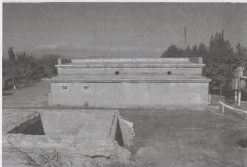
1.4-rasm. Farg'ona viloyatidagi qayta qurish rejasiga kiritilgan «Dang'ara» nasos stansiyasining umumiy ko'rinishi.
