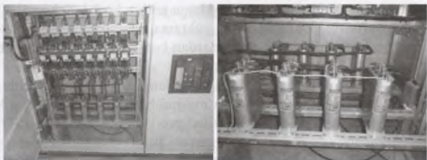
13.4-rasm. Elektr tarmog'ining reaktiv quvvatini kompensatsiyalash qurilmasi.
