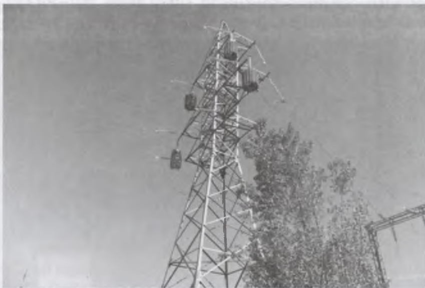
1.2-rasm. Kuchlanishi 110 kV li havo liniyasi.
