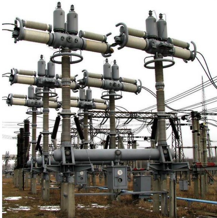
14.6- rasm. Havoli uzgichlarning tashqi ko'rinishi
