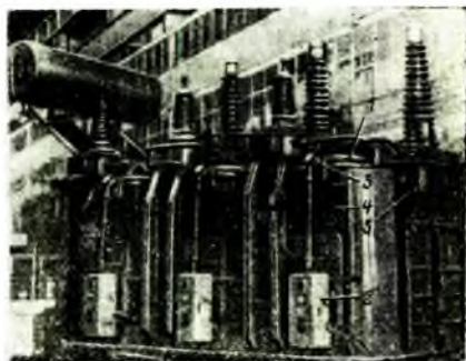
Рис. 31.8. Монтаж РПН типа SAV 35/1600 на третьей сборке автотрансформатора 125 мВ · А, 220 кВ.
