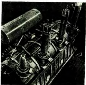
Р и с 31.10. Вакуумирование трансформатора 40 МВА, 330 кВ.
