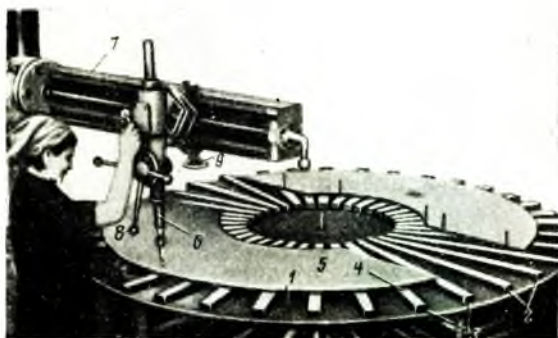
Рис. 30. 8. Сборка клепаной изоляции.
