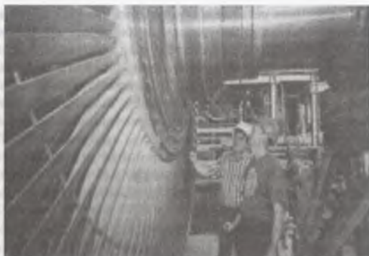
Рис. 2.1. Осмотр последней ступени РНД турбины К-800-240 Талимарджанской ТЭС
