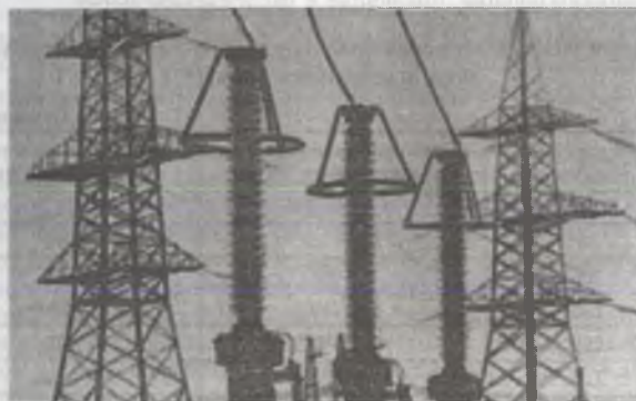
Рис. 2.11 . Ограничитель перенапряжения ОПН-220/154/20/600 IVУХЛ1.01 На Талимарджанской ТЭС
