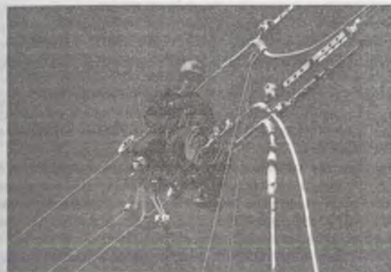
Рис. 3.7. Обработка шлейфов ВЛ 500 кВ Ново-Ангренская ТЭС ПС «Узбекистанская»
