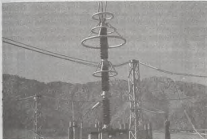
Рис. 2.7. ИС «Согдиана»-500 кВ. Ограничитель перенапряжений 500 кВ.
