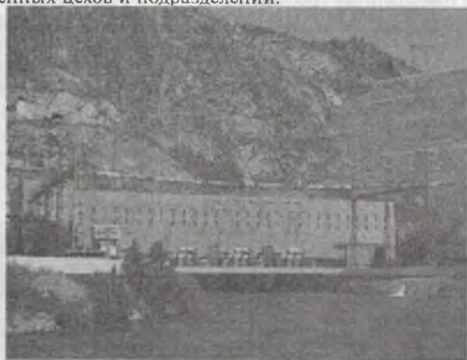
Рис. 3.6. Здание Чарвакской ГЭС.
