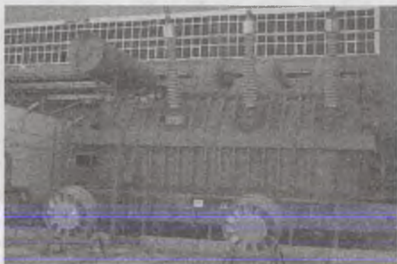
Рис. 2.8. Повышающий трансформатор типа ТНЦ, мощностью 1 млн. кВА, напряжение 220 кВ.
