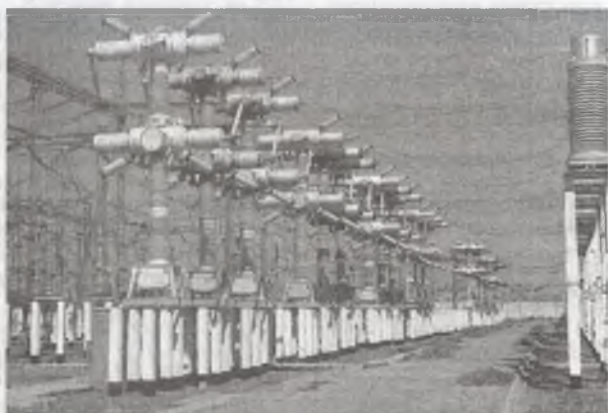
Рис. 2.6.ОРУ-500 кВ Талимарджанской ТЭС (Выключатель ВВБ-500).
