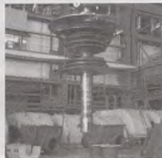
Рис. 2.3. Транспортировка РНД. Снятие дисков РНД турбины К-800-240 ТГ-1 Талимарджанской ТЭС
