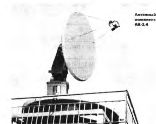
Рис. 8.1. Наземный приемный комплекс НПК-2,4
