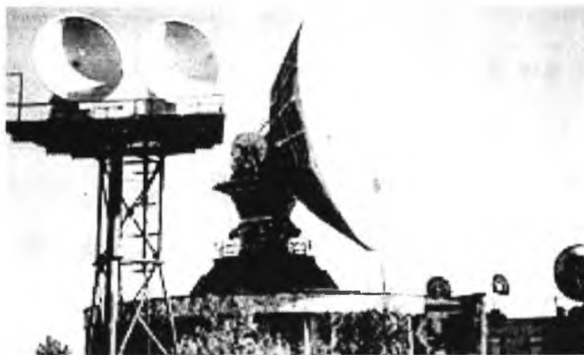
Рис. 8.2. Станция космической связи «Орбита»
