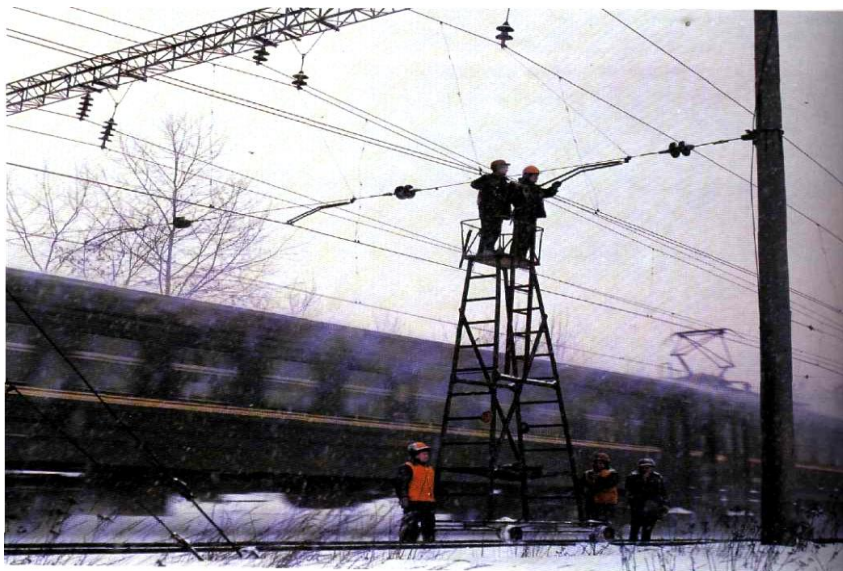
8.7-rasm. Kontakt tizimlarni joriy ta‘mirlash
