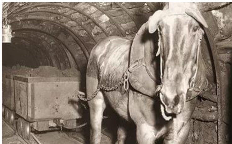
2.1-rasm. Dastlabki ot kuchi yordamida harakatga keluvchi ko'mir koni va shaxtalardagi temir yo'l izlari.
