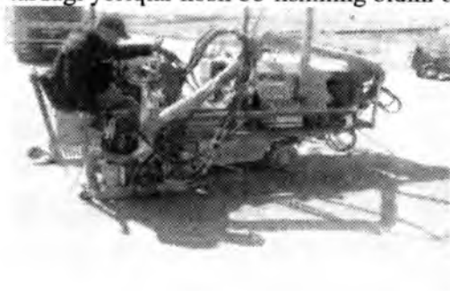
4.30-rasm. Ko'ndalang va bo'yлама choklarning ochildishi
