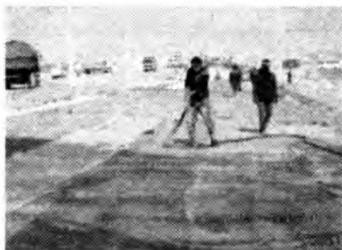
4.38-rasm. Yangi yotqizilgan sementbeton qoplamasi qarovi uchun yangi uslub
