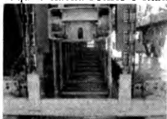
4.27-rasm. Ko'ndalang va bo'yлама choklarga shtirlar va armaturalarning avtomat ravishda o'rnatilishi
