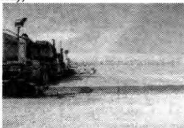
4.29-rasm. Qoplamasi yuzasi g'adir-budir qilinib, keyin plyonka hosil qiluvchi moddani purkash ishlari avtomatik ravishda bajarilishi
