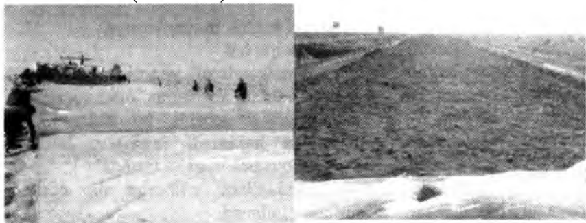
4.24-rasm. Yuqori haroratlarda yotqizilgan qoplama qarovini bajariladigan ishlar ketma-ketligi
