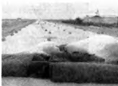
4.38-rasm. Yangi yotqizilgan sementbeton qoplamasi qarovi uchun yangi uslub
