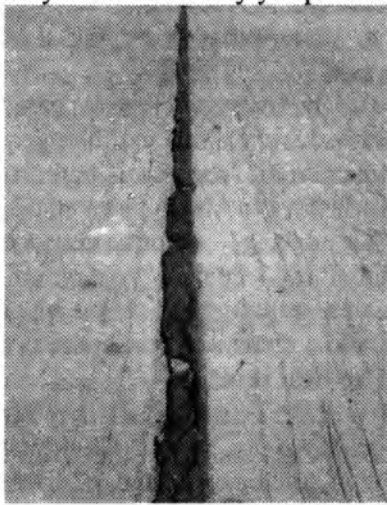
4.36-rasm. Issiq ob-havoda siqilish choklaridagi mastikaning qoplama yuzasiga chiqib qolishi
