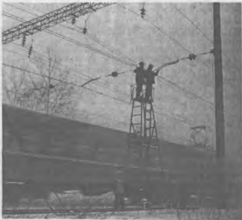
7.7-rasm. Kontakt tizimlarni joriy ta'mirlash.
