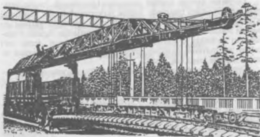
4.6-rasm. Yo'l panjarasini yo'l yotqizuvchi UK-25 mashina bilan qo'yish.
