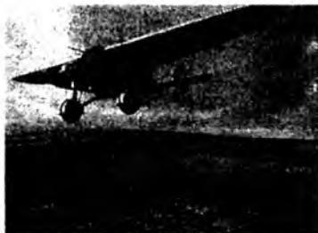
Не так просто оказалось заставить танк взлететь. Осенью 1942 года (по другим данным — 1943-го) были проведены первые и, судя по всему, последние испытания «Крыльев танка». Танк взлетал с трудом, и в полете двигатель начал перегреваться. Летчику-испытателю Сергею Анохину, благодаря своему профессиональному мастерству, удалось успешно совершить посадку. Тем не менее, *испытательный полѐт*
