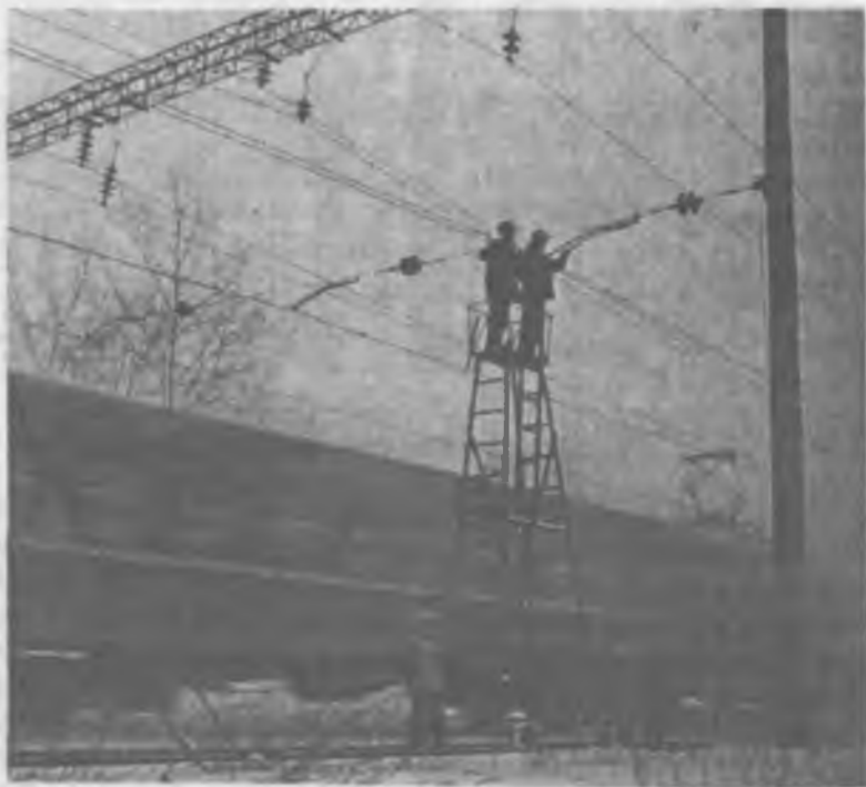
7.7-rasm. Kontakt tizimlarni joriy ta'mirlash.
