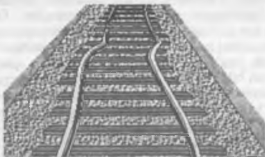
5.7-rasm. Yo'lining qiyshayib ketishi.
