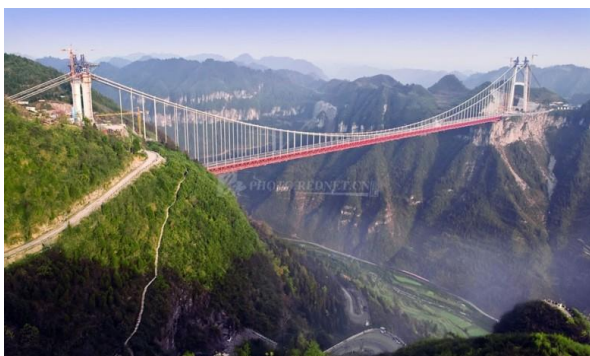
Китай. Висячий мост "Айчжай", подвесной пролёт 1176 м
