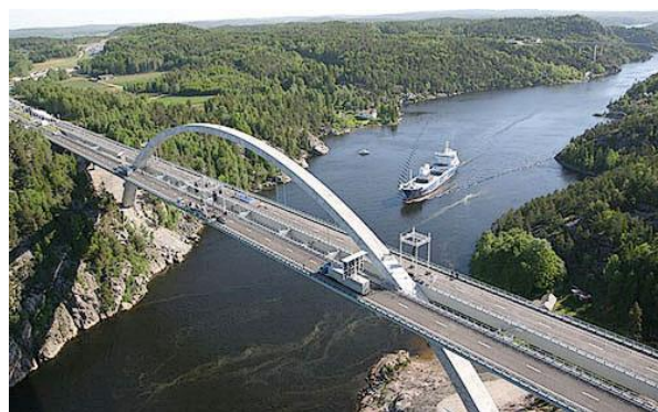
Норвегия, арочный мост Svinesund, пролёт 704 м
