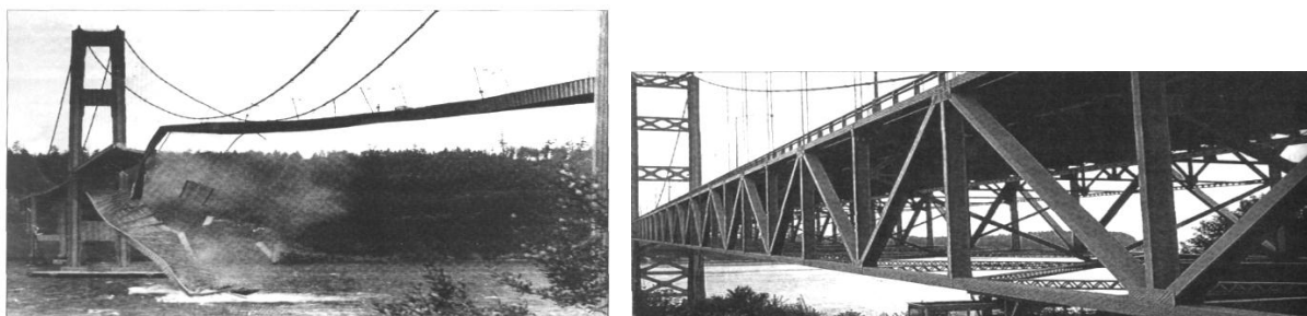
Рис. 3.18. Висячий мост Такома Нерроуз через реку Такома: сверху – разрушение моста, снизу – тот же мост, усиленный фермами, обеспечившими жесткость плиты пролетного строения
