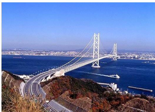
Япония, мост Акаси-Кайкё, подвесной пролет 1991 м
