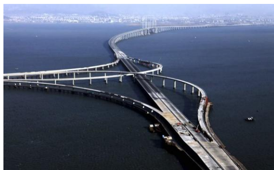
Китай, мост Циндао Хайван, длина моста 42,5 км
