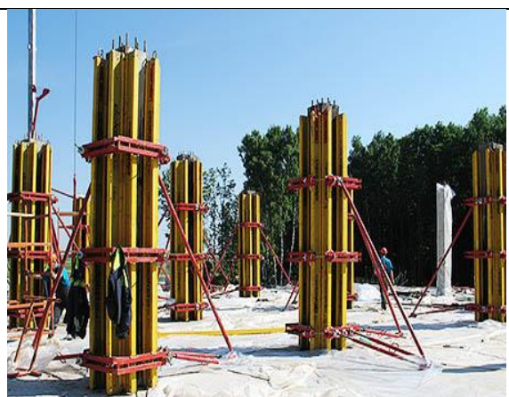
15.17-rasm. Ustunlar uchun yig'ilgan to'sin-rigel qolip.
