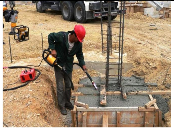
15.46-rasm. YAxlit va alohida turuvchi poydevorlar betonini ichdan tebranish beruvchi titratgichda zichlash jarayoni.
