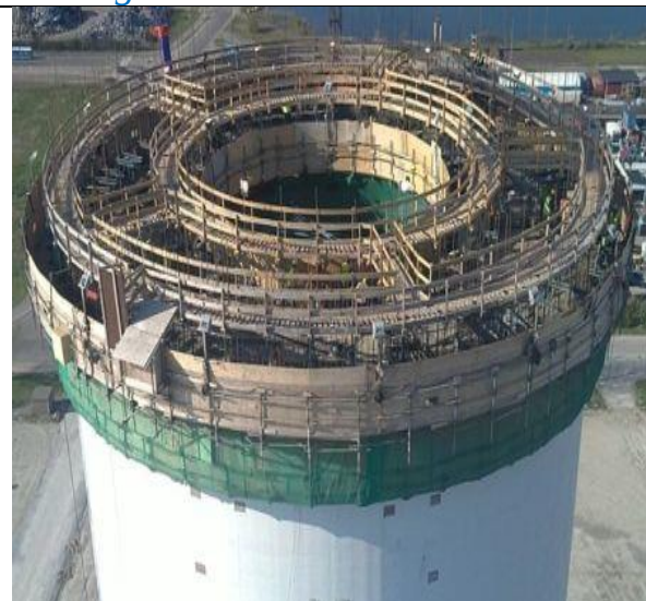
15.13-rasm. Vertikal sirpanuvchi qoliplarda barpo etilayotgan inshootlar.
