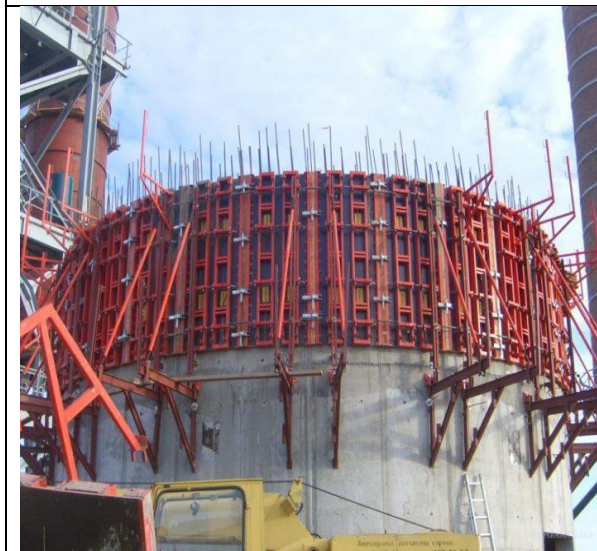
15.13-rasm. Vertikal sirpanuvchi qoliplarda barpo etilayotgan inshootlar.
