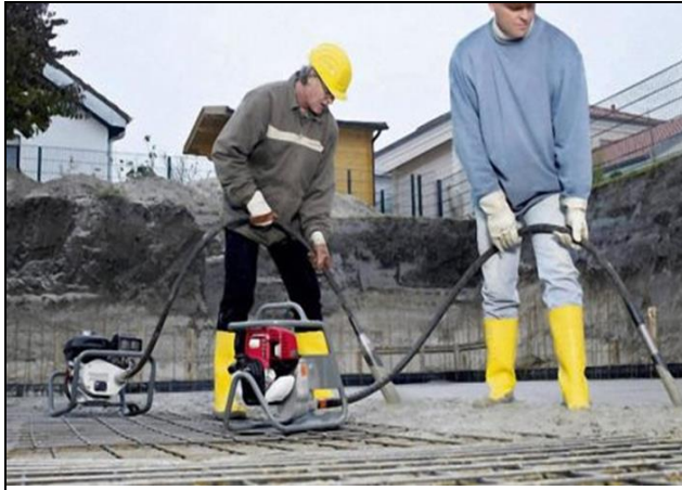
15.46-rasm. YAxlit va alohida turuvchi poydevorlar betonini ichdan tebranish beruvchi titratgichda zichlash jarayoni.
