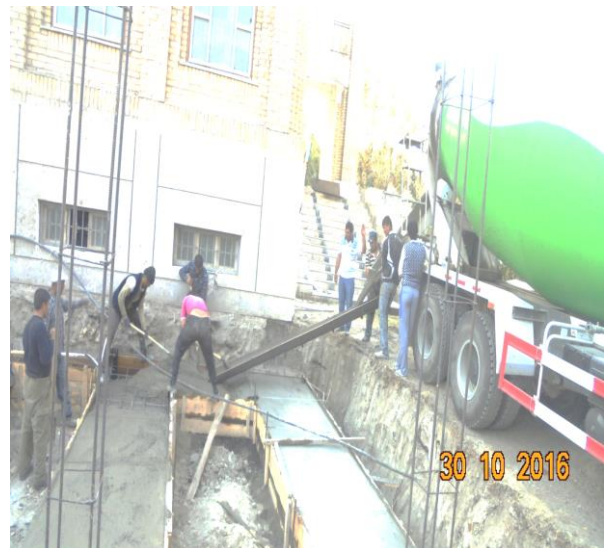
15.38-rasm. ATB Qishloqqurilish bank Buxoro filiali ma'muriy binosi poydevorini betonlash jarayonidan lavhalar.
