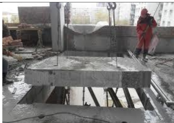
17.3 -rasm. Devor panellarini ajratib olish uchun moslama (a): 1- skoba; 2-fiksatsiya qiladigan barmoq; 3-devor paneli. b, s- tom yopma va ora yopma plitalarni ajratib olish jarayoni.
