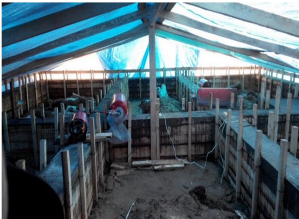
18.16-rasm. Konvektiv issiq oqim yordamiada toza yotqizilgan beton qorishmasini qoliplarda isitish jarayonidan lavha
