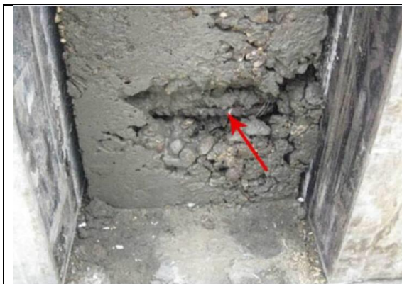
15.47-rasm. Quyma beton poydevor (a) va temirbeton ustun (b) dagi etarli darajada zichlanmagan uchastkalar.
