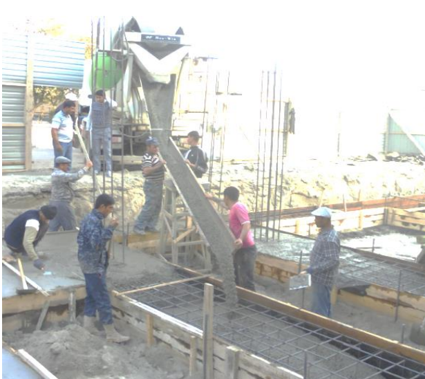
15.38-rasm. ATB Qishloqqurilish bank Buxoro filiali ma'muriy binosi poydevorini betonlash jarayonidan lavhalar.
