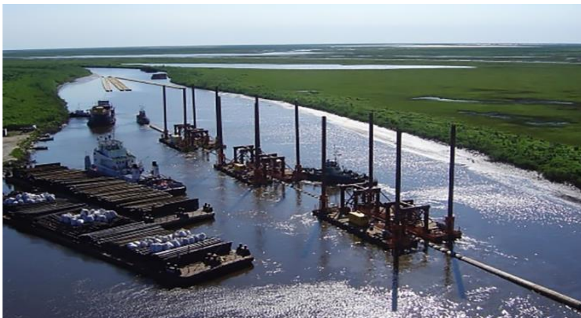
15.57-rasm. Vertikal siljuvchi quvur usulidan foydalanib gidroinshoot qurish jarayonidan lavha (Rossiya)
