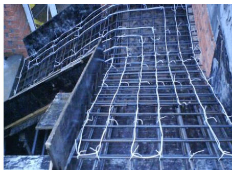
18.11-rasm. Lentasimon poydevor (a) , zinapoya va uning maydonchasi (b) uchun o‘rnatilgan PNSV isitish simi.
