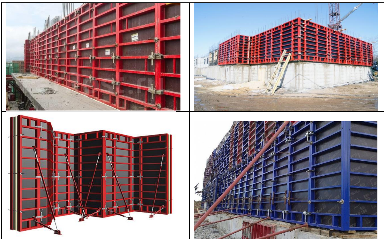
15.5-rasm. Quyma temirbeton devorlar uchun yig'ilgan yirik shchitli qoliplar
