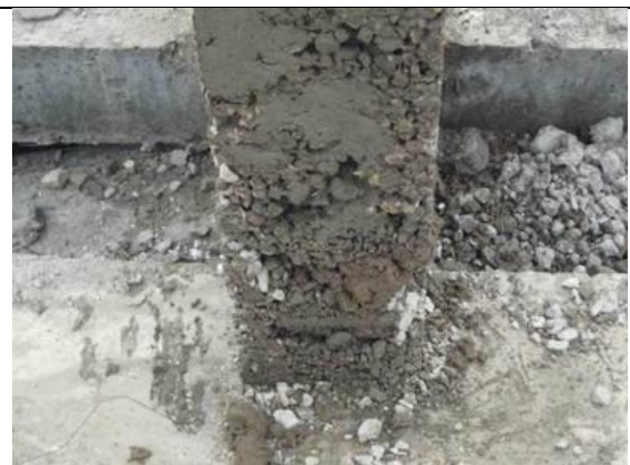
15.47-rasm. Quyma beton poydevor (a) va temirbeton ustun (b) dagi etarli darajada zichlanmagan uchastkalar.
