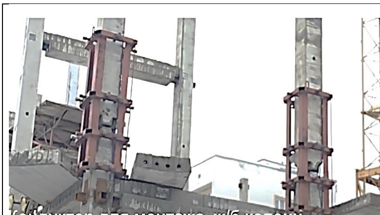
12.18-rasm. Yakka konduktorda loyihaviy holatda o'rnatilgan ustunlarni vaqtinchalik mahkamlash jarayonidan lavha.
