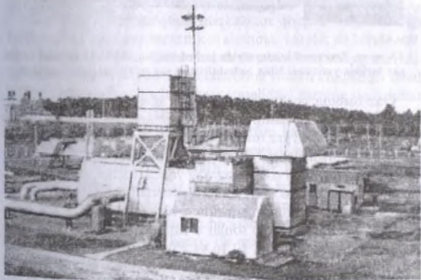
1.9- rasm. GPA-S-16 rusumli aviatsion gaz turbina yuritmasi bilan birlashgan gaz so'rib chiqarish agregati.
