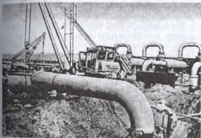
7.4- rasm. Nagctatellar o'ramining quvurlar uzelinesi quvur qo'yish krani yordamida o'rnatish.
