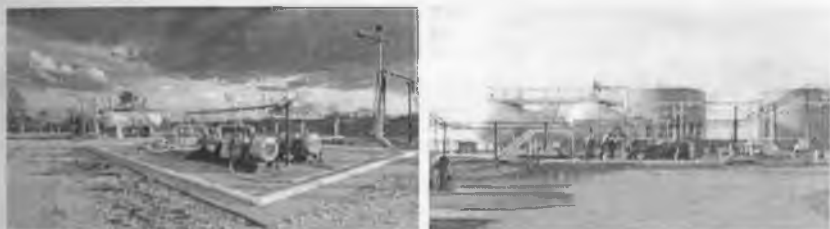
4.1-rasm. Siquvchi nasos stantsiyasi umumiy ko'rinishi
