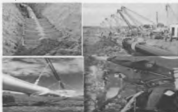
7.2-rasm. Quvurlarni yotqizish usullari
