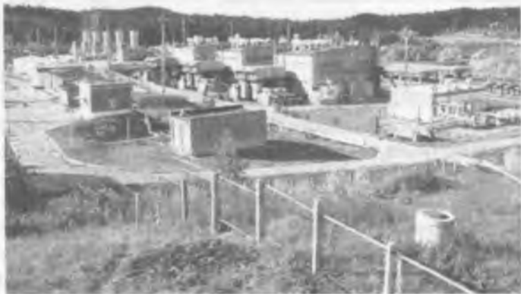
15-rasm. Kompresor stansiyasining umumiy ko'rinishi.
