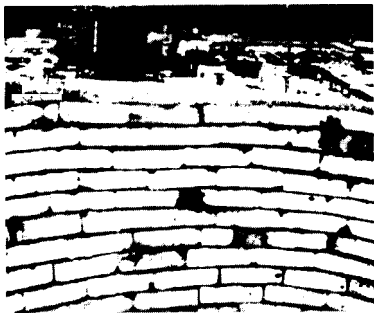
Рис. 2.94. Дефекты дымовой трубы установки Л24/7
