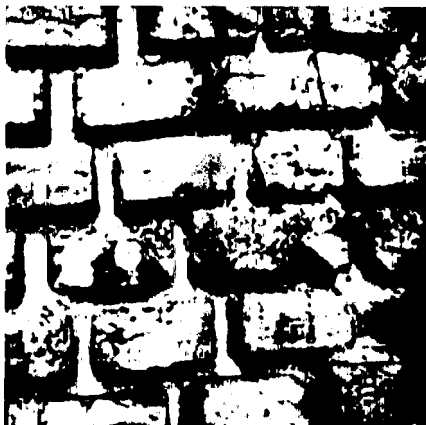
Рис. 2.95. Выветривание раствора кирпичной кладки
