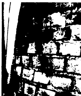
Рис. 2.97. Выкрашивание кирпича
