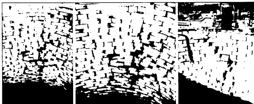
Рис. 2.100. Разрушение футеровки
