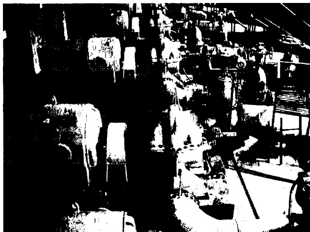
Рис. 2.182. Общий вид насосной установки
