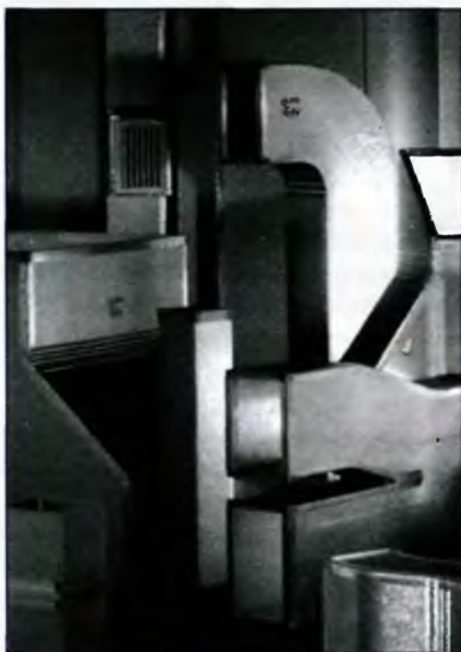
Рис. IV.37. Полугибкие воздуховоды марки METALFLEX ALU
