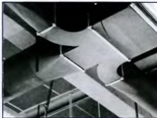
Рис. IV.35. Конструкция фланцев с «европрофилем»
