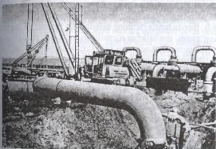
7.4- rasm. Nagnetatellar o'ramining quvurlar uzelinesi quvur qo'yish krani yordamida o'rnatish.
