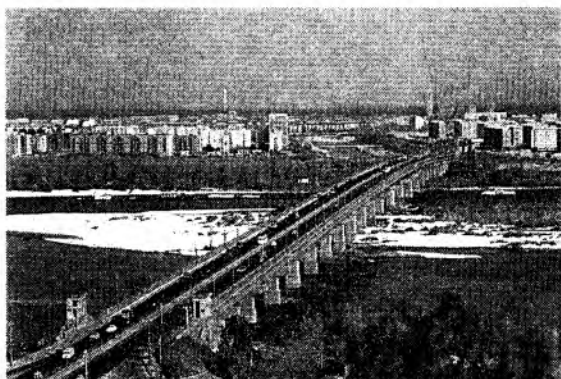
Рис. В4. Уникальное сооружение — цельносварной автодорожный мост им. Е.О. Патона через Днепр в Киеве. Длина моста 1542 м, общая масса 10 тыс. т, 20 пролетов по 58 м и 4 судоходных пролета по 87 м
