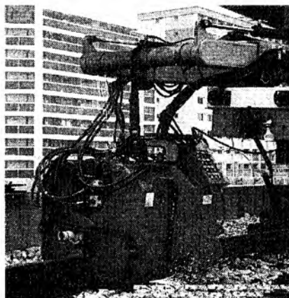
Рис. В6. Стыковая сварка рельс
