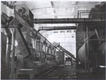
6.4-rasm. 2CB-10 rusumli barabanli quritkichlar va paxtani tozalash uskunalari o'rnatilgan QTB ning umumiy ko'rinishi.
