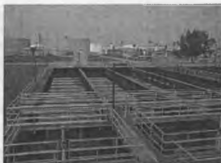
44-rasm. To'rtburchak birlamchi tindirgichlar.
