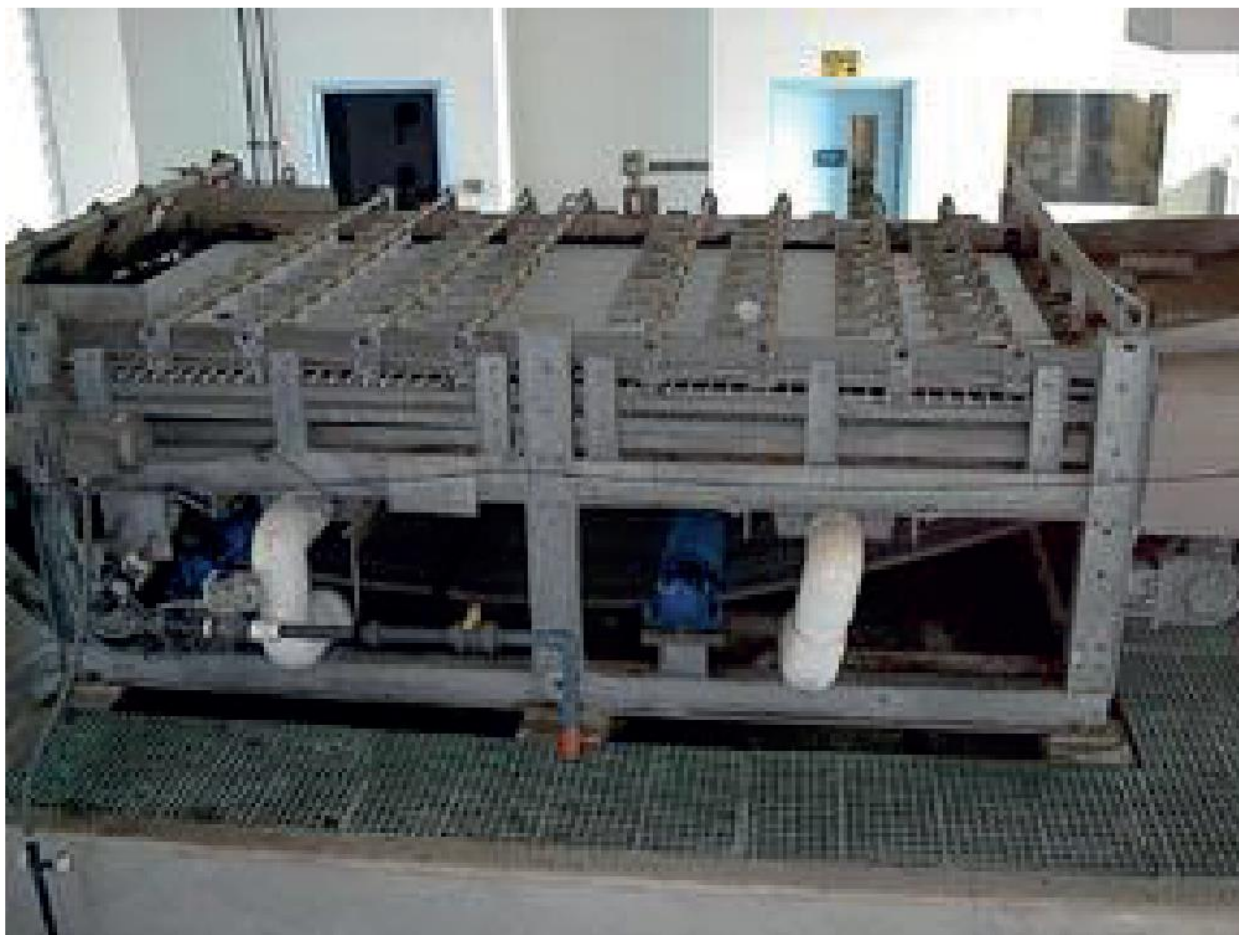
83 rasm. Tasmali gravitatsion zichlashtirgich rasmi. (foto)
