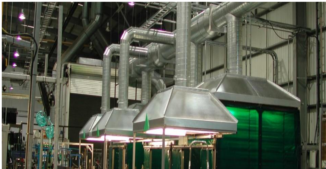
35-rasm. Maxalliy havo olib ketuvchi ventilyatsiya (tortuvchi shkaf)
