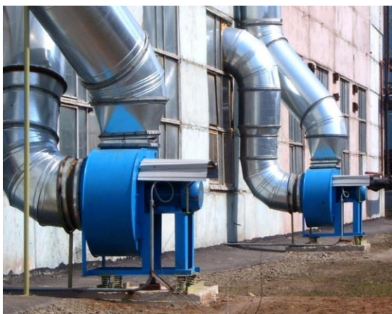
33-rasm. Umumiy havo olib keluvchi ventilyatsiya qismlari
