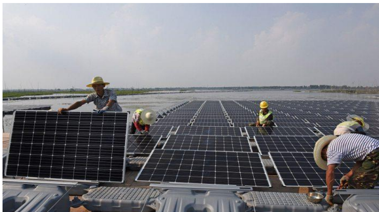
23-rasm. Xuaynan suvda suzuvchi energiya to'plovchi batareyalari.
