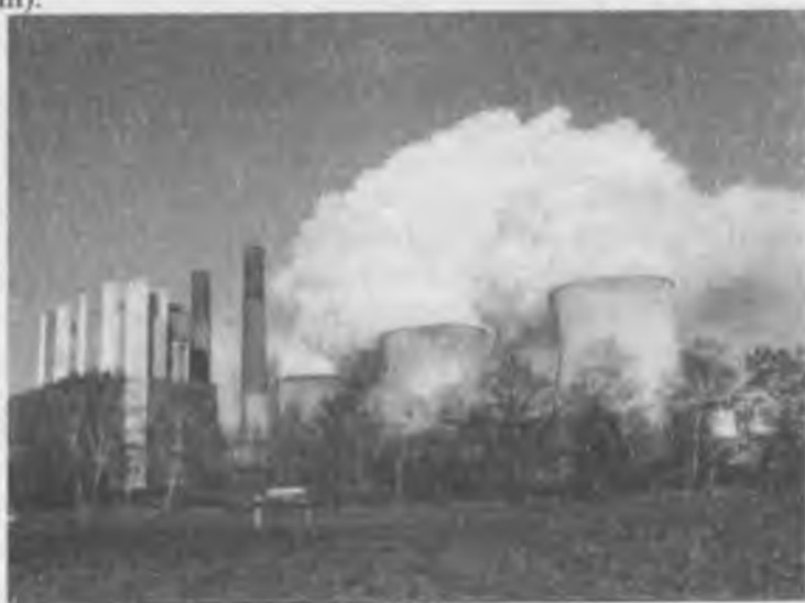
28-rasm. Issiqlik elektr stansiyasi.
