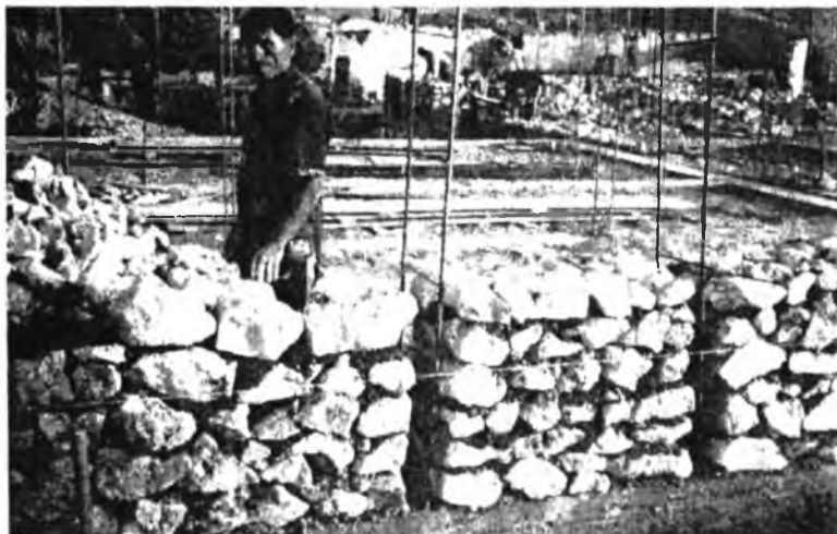
Рис. 2.14. Строительство сейсмостойких зданий из бутового камня в Кашкакадарьинской области Узбекистана
