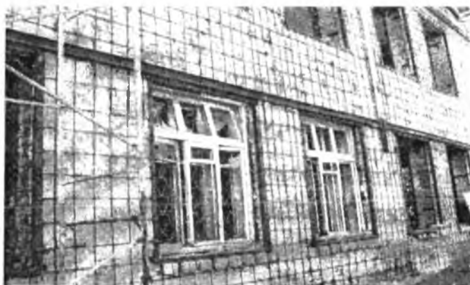
Рис. 2.13. Пример укрепленного здания школы
