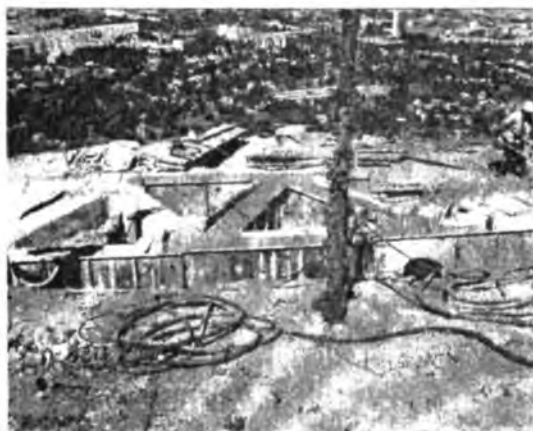
Рис 2.18. Пример мероприятий на оползневом склоне с использованием свай
