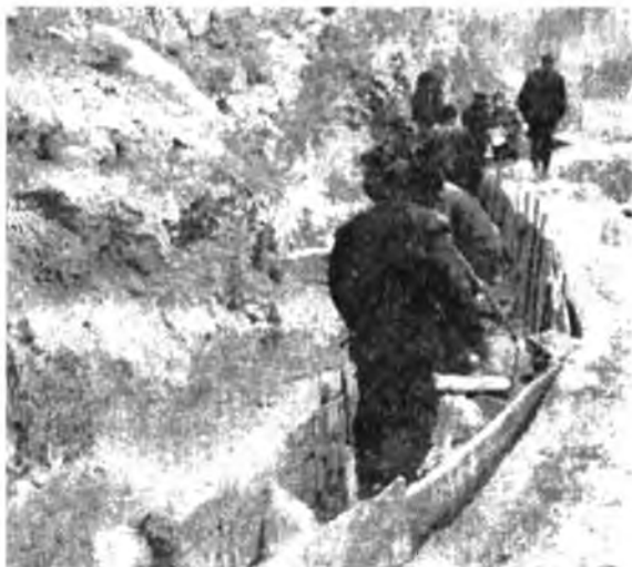
Рис.2.19. Пример гидроизоляции канала над оползнеопасным склоном
