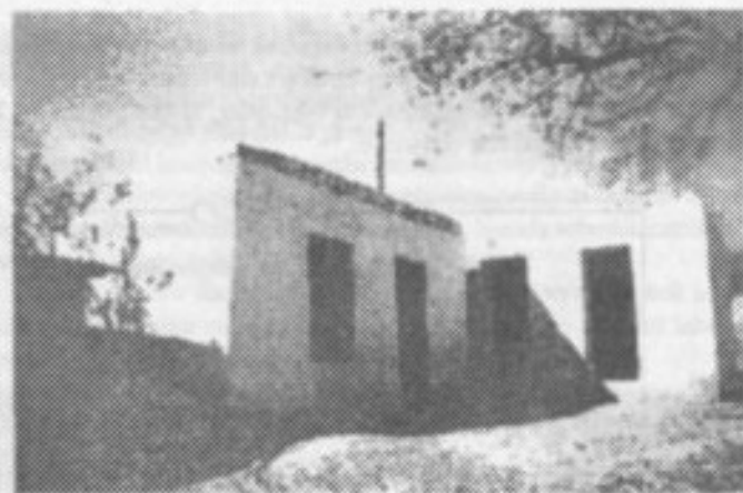
69-rasm. Chapda toq yopman yog'och to'sinli, ichki to'rtburchan o'zakli monolit gil devor konstruksiyali eksperimental bino.
