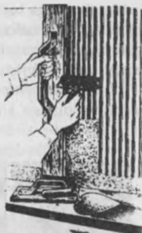
99-rasm. Suvoq qatlamiga g'o'la yordamida ishlov berish.
