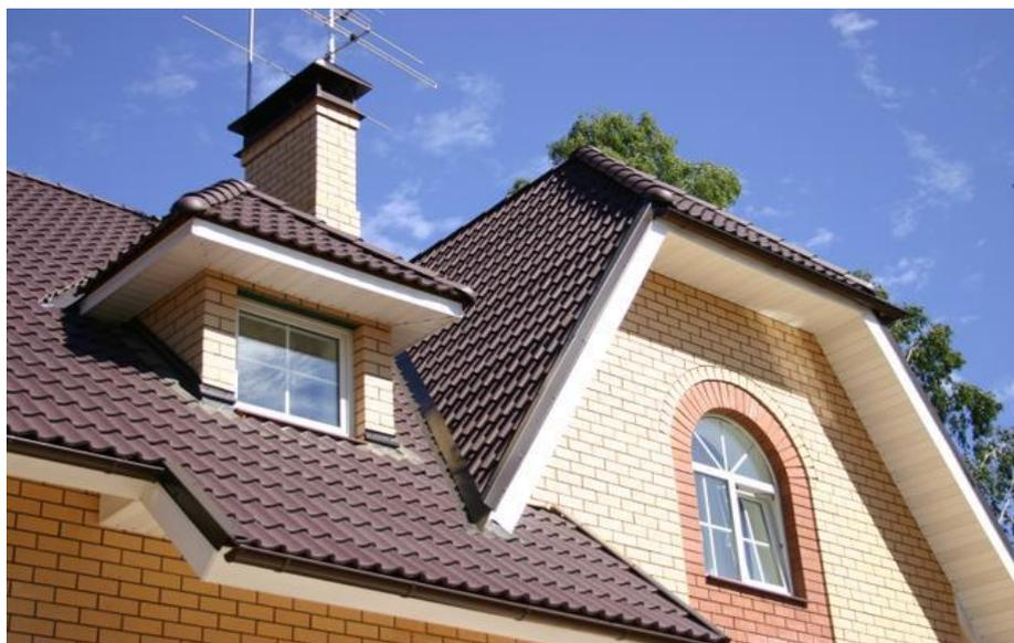
*Рис.2.27. Кровля из металлочерепицы.*
