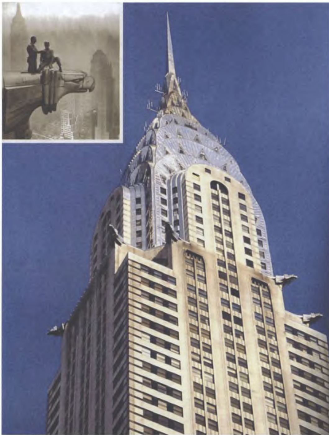
Уильям ван Ален. Крайслер-билдинг, Нью-Йорк, 1930. Строители Крайслер-билдинга на стальной голове орла (59-й этаж)
