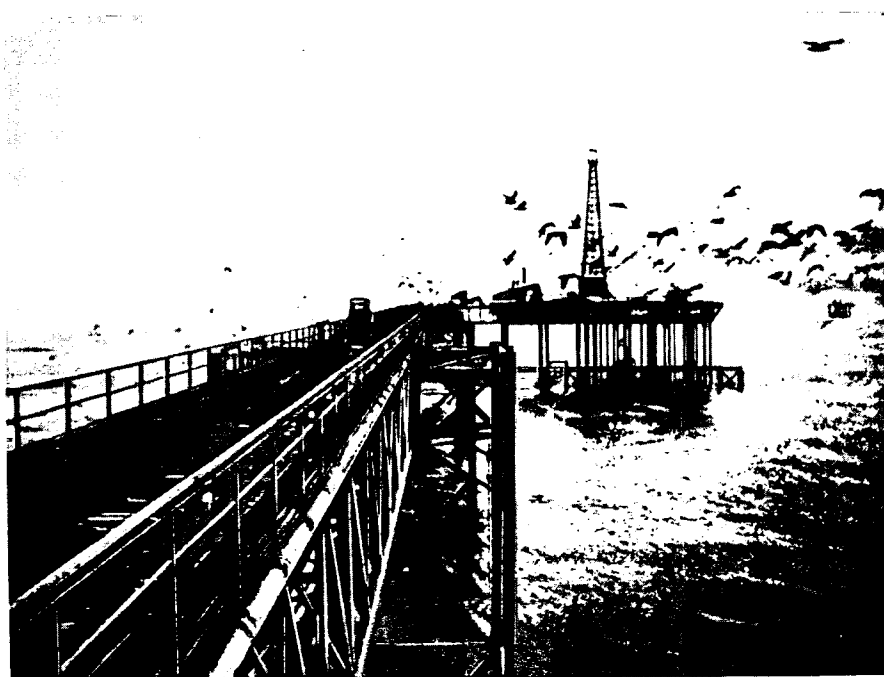
Рис. 21.17. Платформа для добычи нефти в открытом море. Скважина расположена на глубине около 15 м и на расстоянии 11 км от берега в Мексиканском заливе (США, шт. Луизиана, компания «Экссон»).
