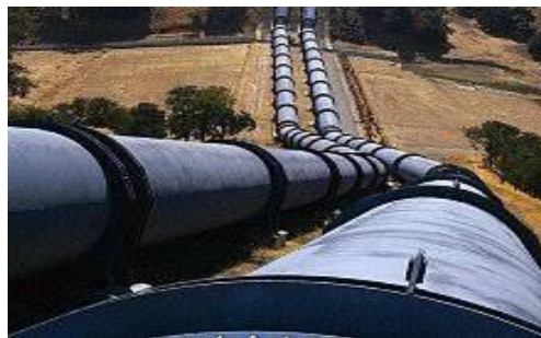
Рисунок-4.6. Общий вид магистрального трубопровода
