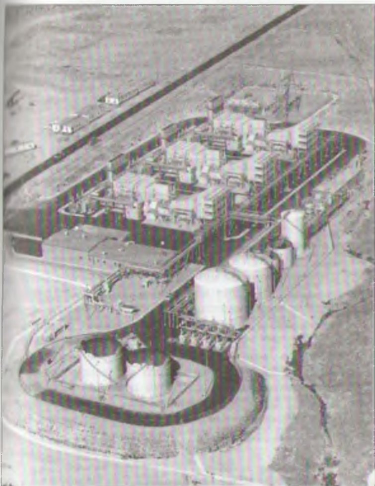
Рис. 15.3. Типичная теплоэлектроцентраль на месторождении тяжелой нефти в округе Керн (Калифорния) (фото Игер Студио, собственность ARCO)
