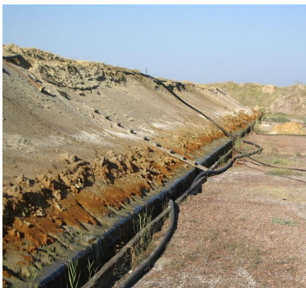
Опытно-промышленная куча биовыщелачивания техногенных отходов.
