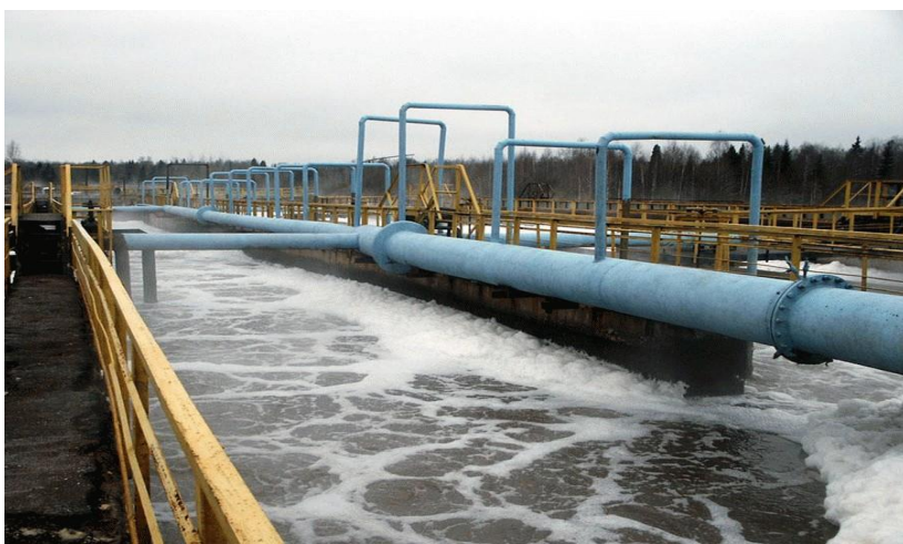
Рис. 9.2.1. Устройство смесителя-окислителя или аэротенка.
