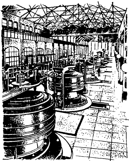
Рис. 7.5. Машинный зал Ниагарской гидроэлектростанции
