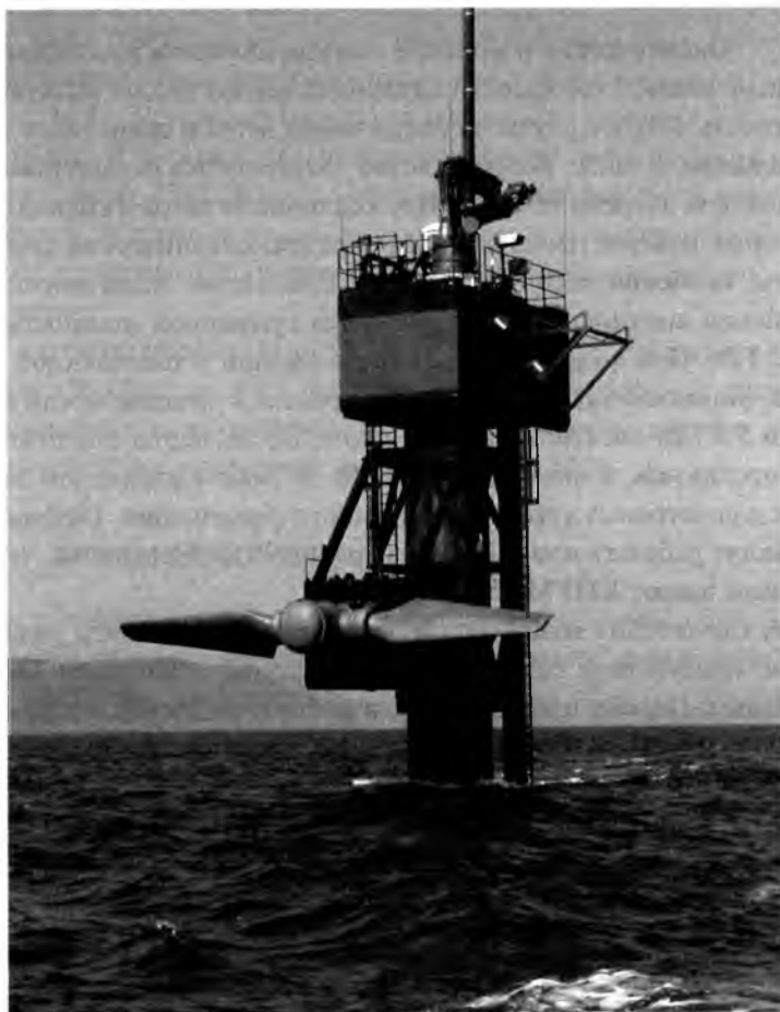
Рис. 14.7. Прототип приливной турбины, установленный вблизи побережья Англии (Девон). Турбина показана в процессе установки. Источник: Marine Current Turbine, Ltd
