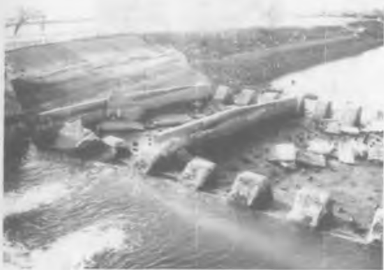
3.2 - rasm. Do'stlik kanalining PK 580 da joylashgan tashlama inshootni pastki befidagi abraziv yemirilishlar
