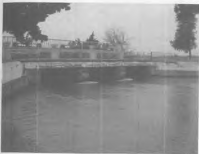
3.4 - rasm. Do'stlik kanali PK 460 da joylashgan gidrouzel oraliq ustunlarining yemirilish holati
