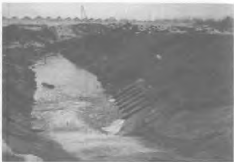
8.4 - rasm. Ta'mirlashdan so'ng g'adir-budurli perepad pastki hefida qolib ketgan beton bo'lagi (1) va uning ta'sirida qiyshaygan oqim hosil bo'lishi jarayoni, hamda qiyshagan oqim urilib ochilib qolgan risberma uchastkasi (2) va suv olib ketuvchi kanalni yuviqun uchastkasi (3) (10.01.2007 y.).
