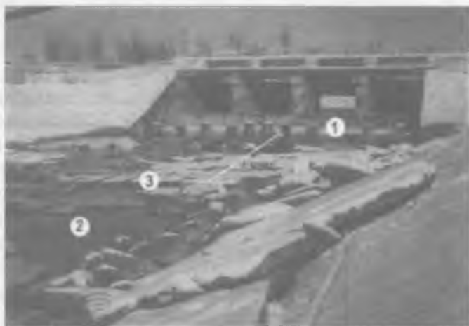
13.17 - rasm. Chap qirg'oq Qorasuv kanali 9+20 piketidagi suv taqsimlash inshootining Qorasuv daryosiga suv tashlamasi pastki befini ko'rinishi: 1 - pirlar; 2 - yuvilish daganagi; 3 - fundament bloklari.
