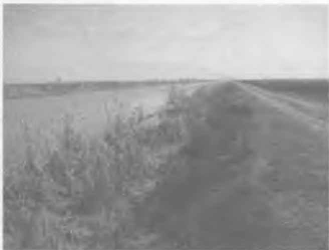
5.2 - rasm. Kanal qirg'og'ini o't bosish holati
