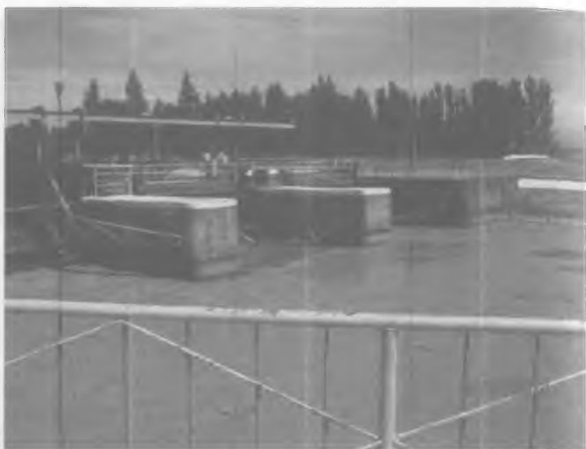
8.6 - rasm Katta Farg'ona kanaliga o'rnatilgan segmentli zatvorlarni pastki befdan ko'rinishi.
