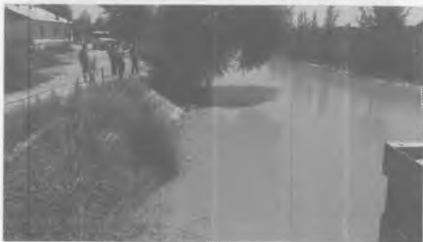
5.6 - rasm. Mang'it arna kanalida oqayotgan suvning ko'rinishi
