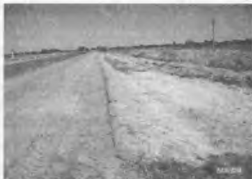
Рис. 2. Участок автомобильной дороги Халкабад – Кегейли, 3 км
