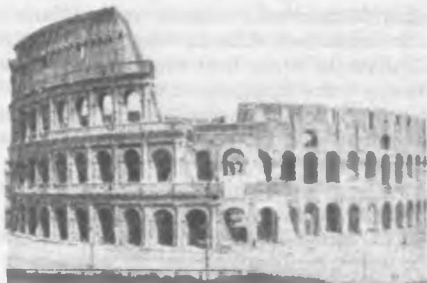
1.1.2-rasm. Kolizey. O'rnatilgan tirgak devorlarda yodgorlikning badiiy kompozitsion tuzilishi inobatga olingan (15-ad., 11-b.)
