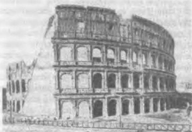
1.1.1-rasm. Kolizey. Ta'mirlash jarayonida o'rnatilgan dastlabki tirgak devor. Yodgorlik tarzi inobatga olinmagan (15-ad., 11-b.)
