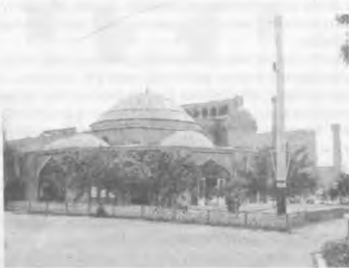
1.4.2-rasm. Samarqand sh. Chorsu savdo gumbazining ta'mirchilikda noan'anaviy bo'lgan metall (tunuka) bilan qoplanganligiga misol (XX asrdagi ko'rinishi).
